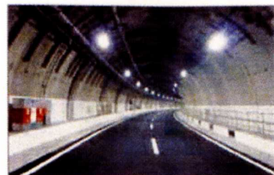
完成間近の山手トンネル
