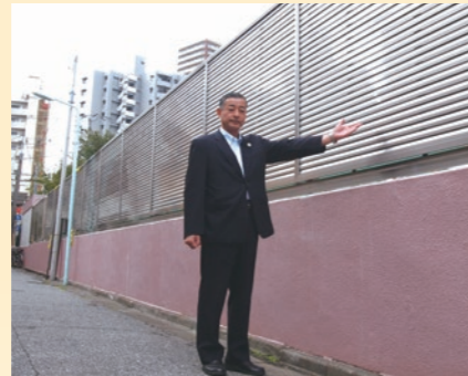
朝日小学校脇のブロック壁を地震による倒壊被害を防ぐため、軽くて安全なフェンスに交換しました。
