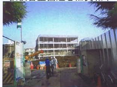
仮校舎整備進む旧真和中
